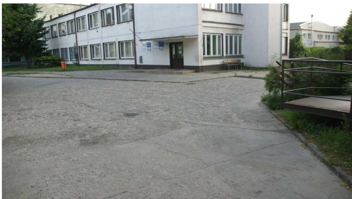
Zdjęcie 2. Nawierzchnia betonowa w rejonie garażu i apteki
