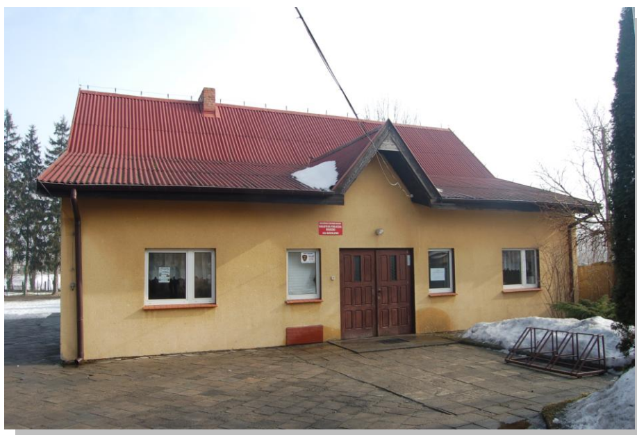
Biblioteka Publiczna (zmodernizowany, dawny budynek gospodarczy szkoły)
