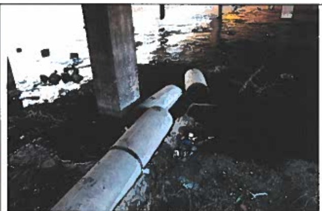
Rogoźno - pod mostem na ulicy Lipowej - 02.01.2020 r.
