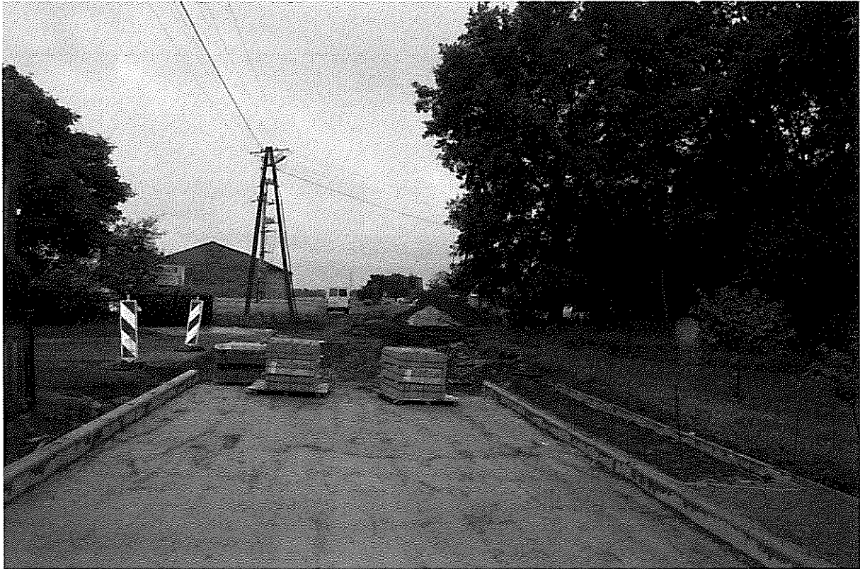
W trakcie budowy
