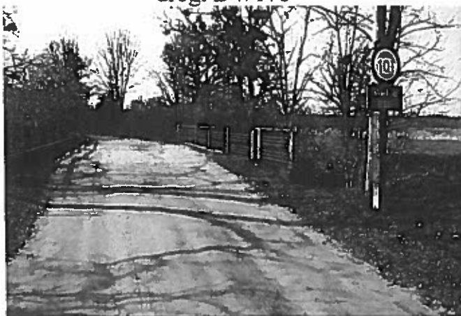
Most na Welnie - jedyny wyjazd w stronę drogi DW178
