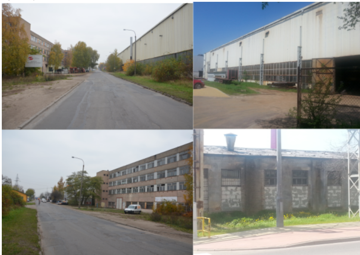
RYSUNEK 45. DOKUMENTACJA FOTOGRAFICZNA - PRZYKŁADY OPUSZCZONYCH, NISZCZEJĄCYCH BUDYNKÓW
