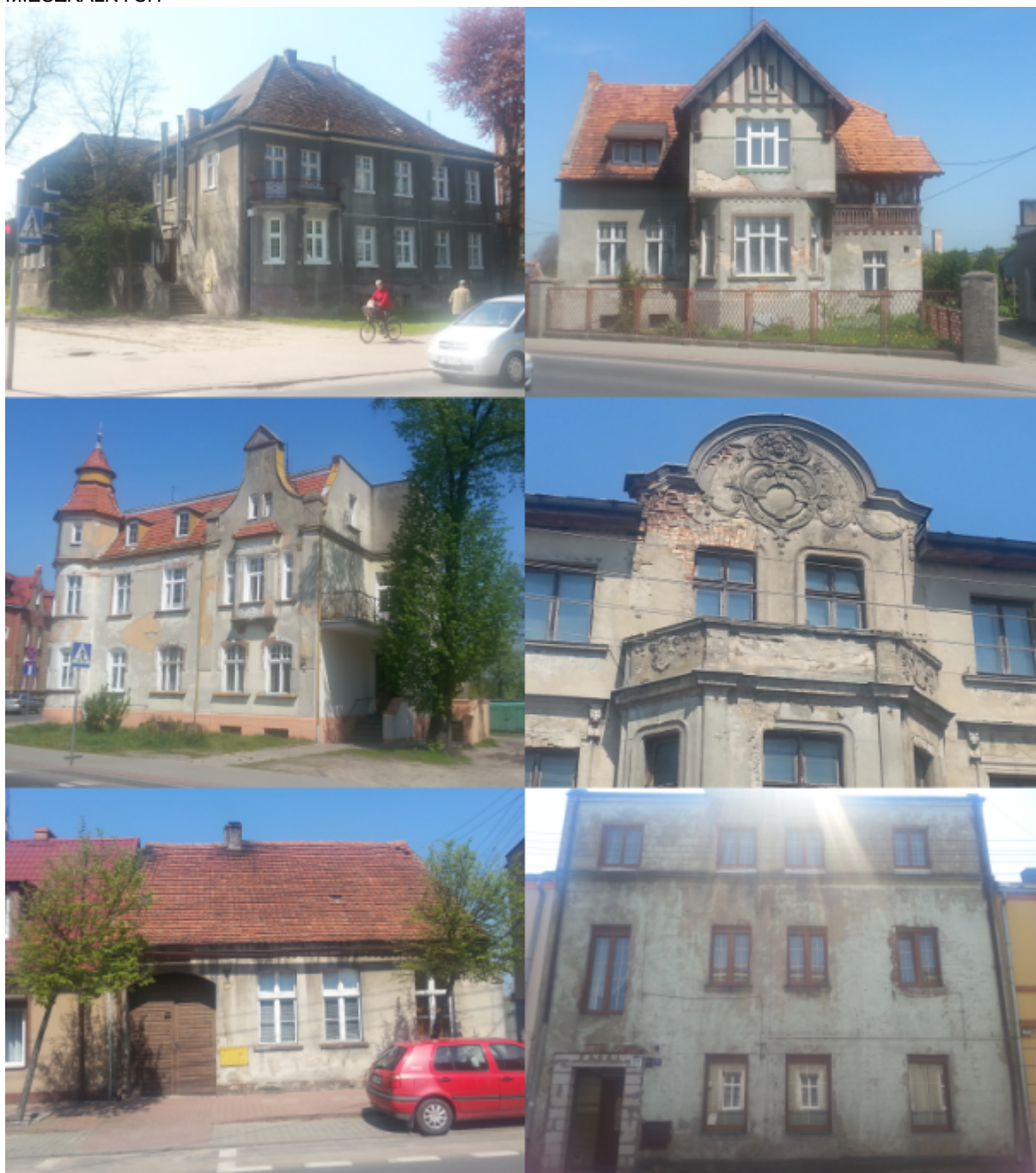
RYСУNEK 42. DOKUMENTACJA FOTOGRAFICZNA - NIEZADOWALAJĄCY STAN TECHNICZNY BUDYNKÓW MIESZKALNYCH
