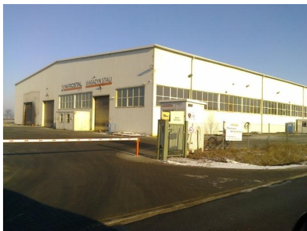
Ryc. 17. Magazyn stali w Garbatce źródło: zbiory prywatne
