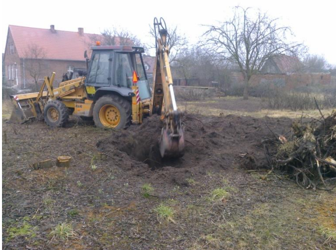
Ryc. 25. Porządkowanie terenu przy świetlicy wiejskiej źródło: zbiory prywatne
